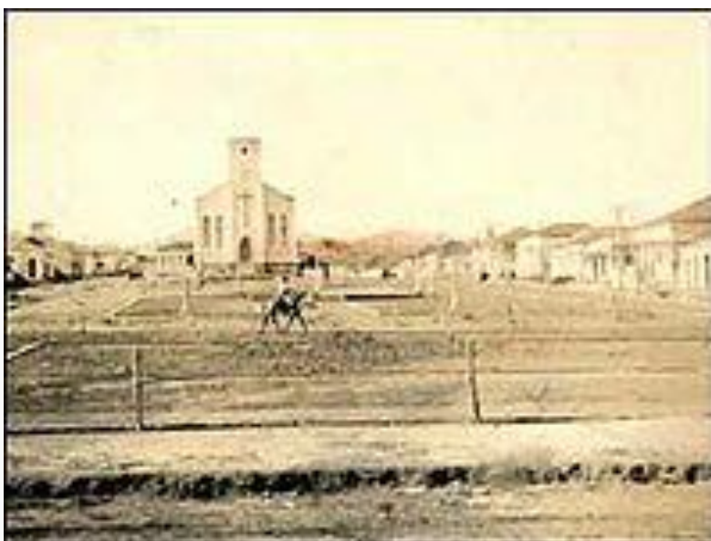
Igreja Matriz em Construção
