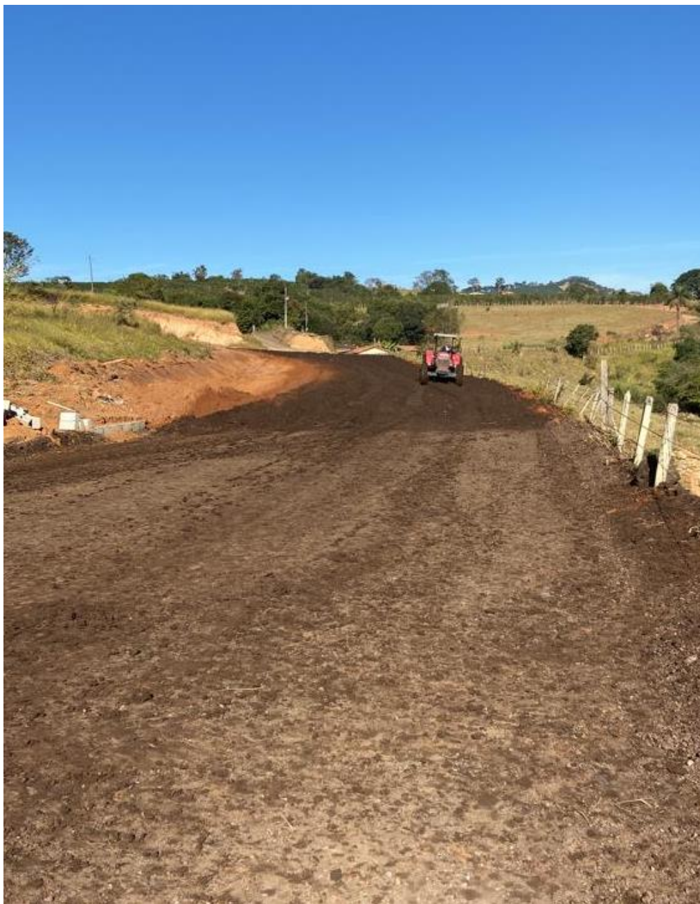
Figura 2: Estrada a pavimentar (Avenida Edivino José dos Reis).
