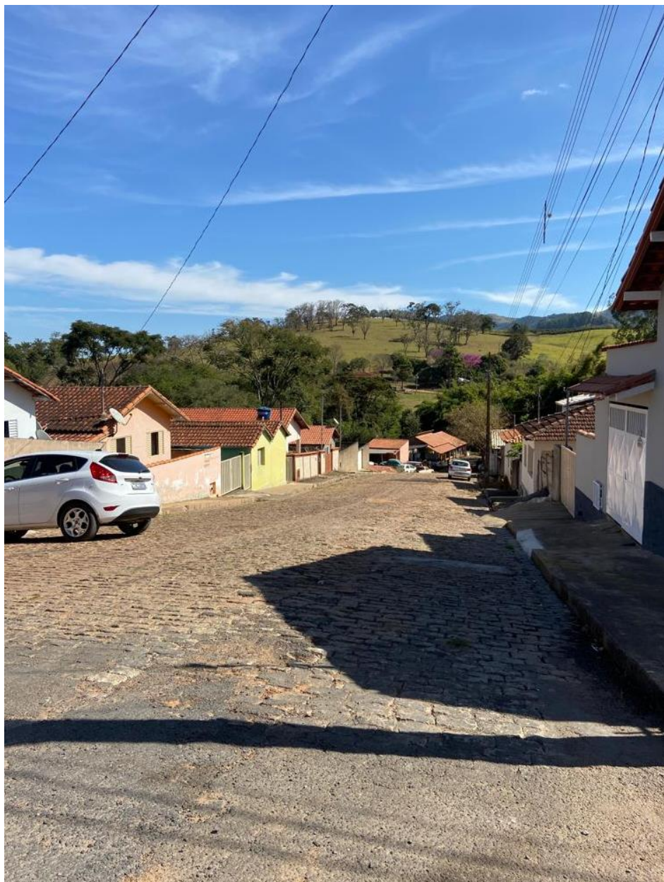
Figura 4: Rua a recapear (Rua Santo Antonio).
