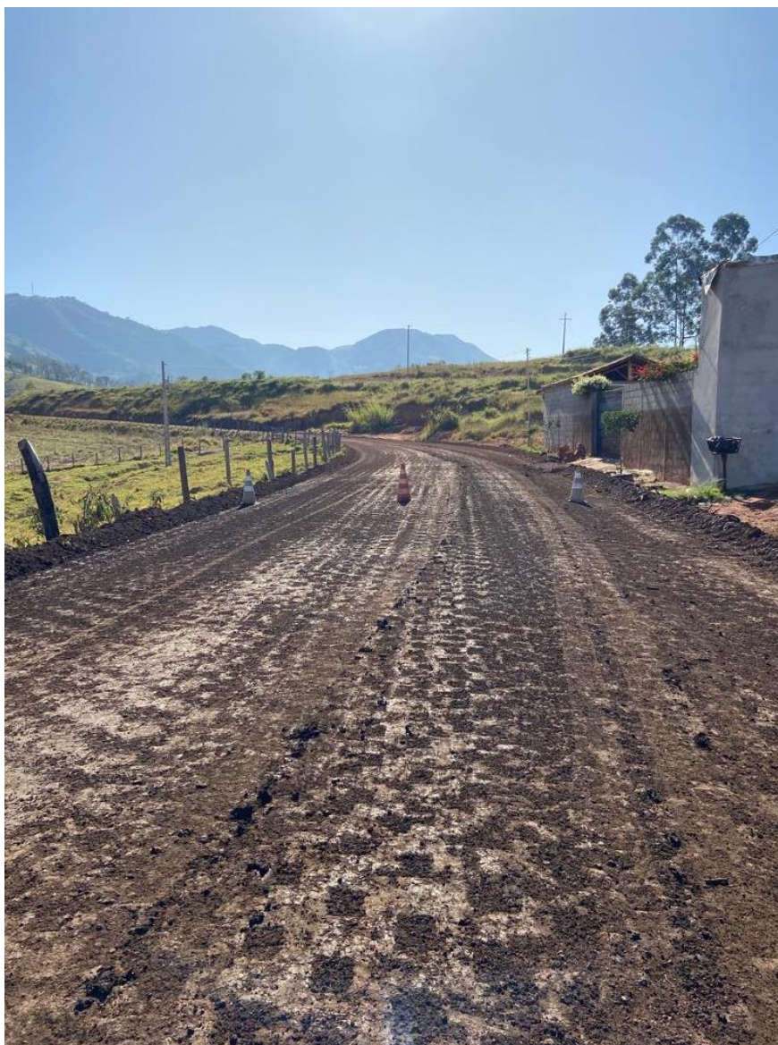
Figura 1: Estrada a pavimentar (Avenida Edivino José dos Reis).
