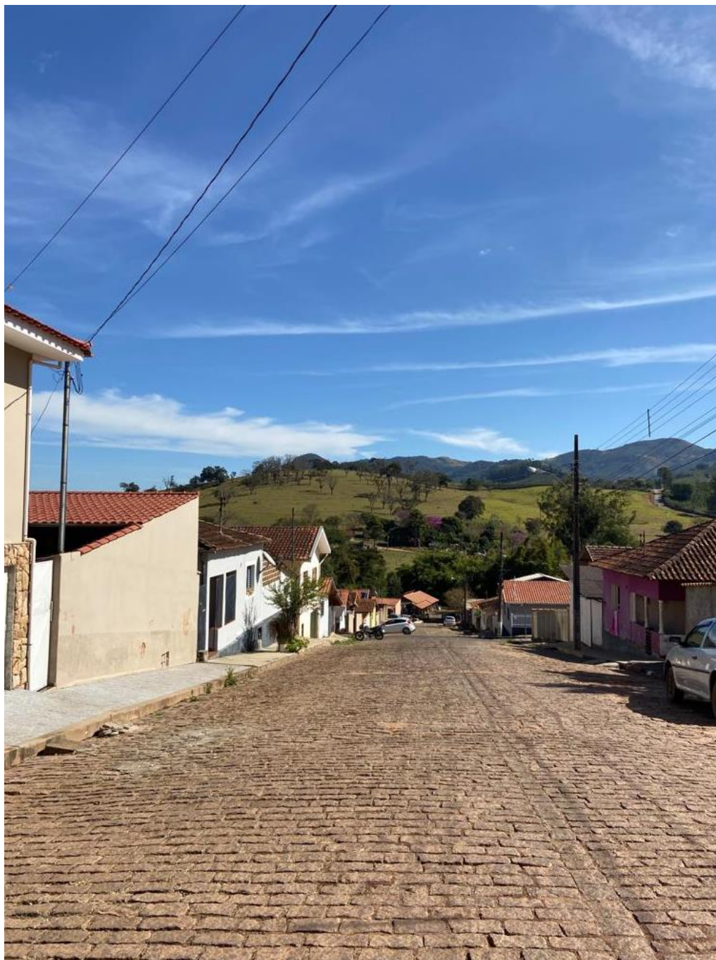
Figura 3: Rua a recapear (Rua Santo Antonio).
